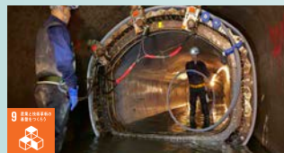
管路更生工法 (SPR工法)
