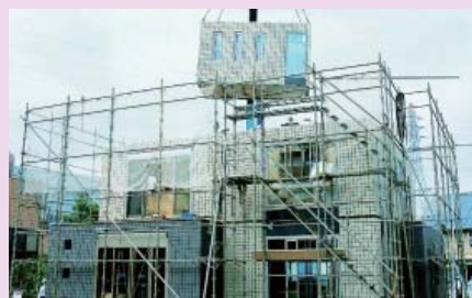
棟上げもわずか1日で完了する快速施工
