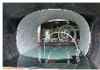
更生工法(新製管技術)
