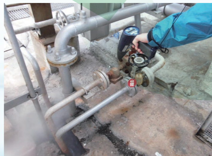
生産事業所における設備の熱漏れ状況の点検
