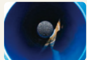
錆びないので、敷設から9年経過後も内部は新品同様
