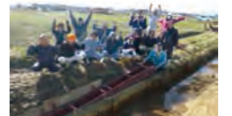
田んぼに設置された魚道
