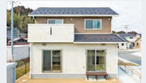
完成した災害公営住宅
