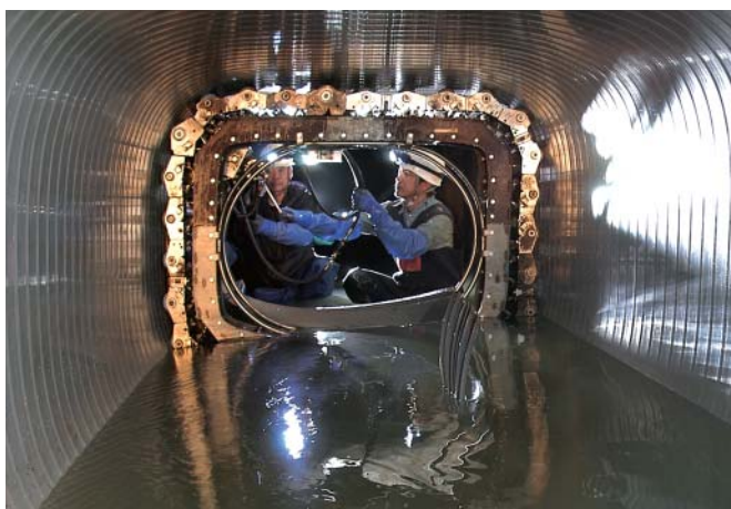
通水しながらでも施工ができ、あらゆる断面に対応できる「SPR工法」
