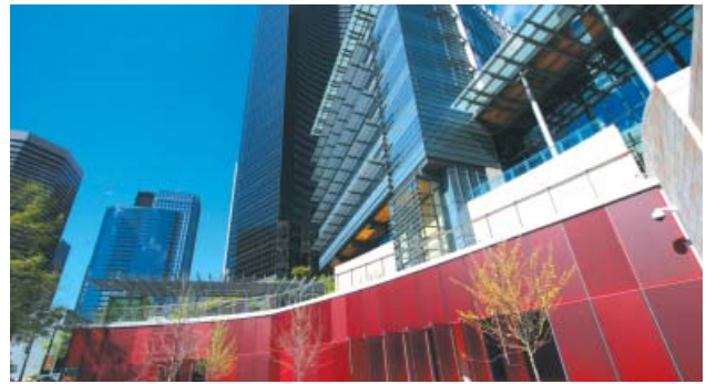
米国シアトル市のシティホール(市庁舎)で、積水化学の合わせガラス用中間膜「エスレック®フィルム」が採用されています。
