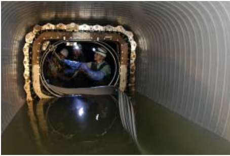
道路を開削せずに管路更生ができる「SPR工法」
