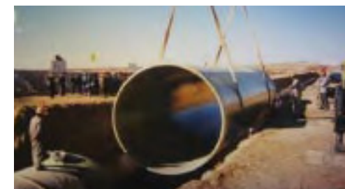
強化プラスチック複合管の施工風景
