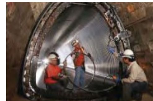
道路を開削せずに管路更生できる「SPR工法」
