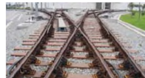
FFUまくらぎ使用例 広州地下鉄8号線 車両基地
