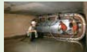
道路非開削で老朽管きよを更生し、廃棄物を抑制する「SPR工法」
