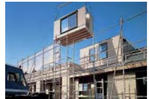
棟上げもわずか1日で完了する快速施工
