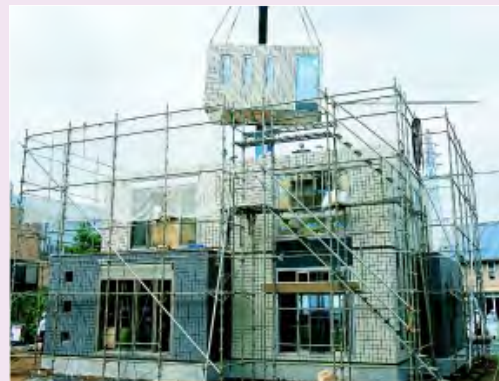
棟上げもわずか1日で完了する快速施工
