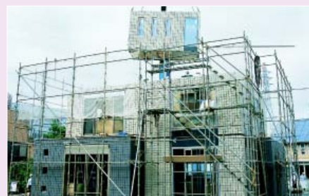
57棟上げもわずか1日で完了する快速施工
