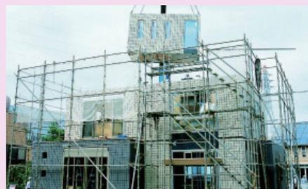
棟上げもわずか1日で完了する快速施工
