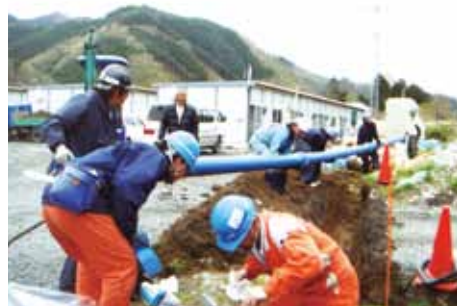
仮設配管の敷設現場(岩手県釜石市)
