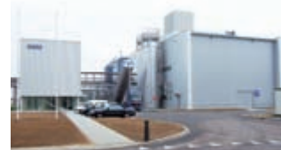
中間膜原料樹脂工場 (オランダ・ヘレーン市)
