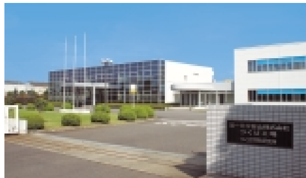
第一化学薬品株式会社つくば工場(茨城県龍ヶ崎市)
