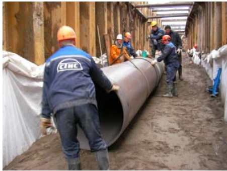
VKS 社によるエスロン®RCP®施工事例 φ1000mm
