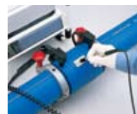
EFソケットの施工
