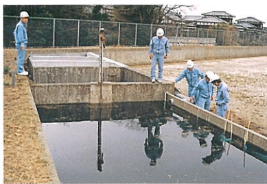
①遮断ゲートによる流出の防止
