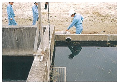
②緊急時油分離槽への導水
