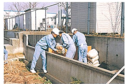
③土嚢による汚染拡大の防止
