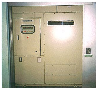
パッケージ型触媒燃焼設備 (武蔵工場)
