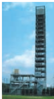
エスロンタワー(ビル配管試験設備)
