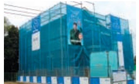
粉塵・汚染対策:清潔感のある飛散防止ネット
