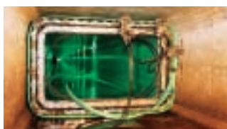
ボックスカルバート(矩形渠)更生事例
