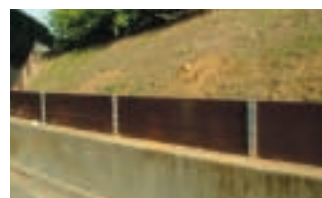
FFU廃材を利用した土留板
