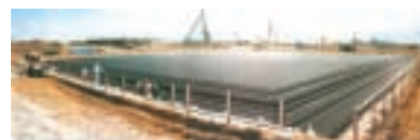
施工事例(調整池4000m 3 )
