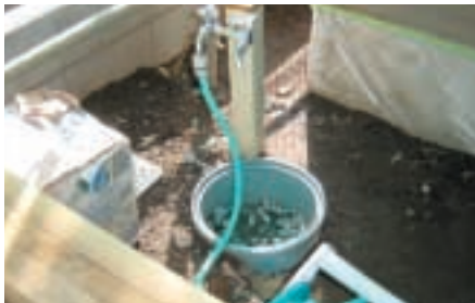
汚染対策:仮設水道排水処理用の浸透枘設置
