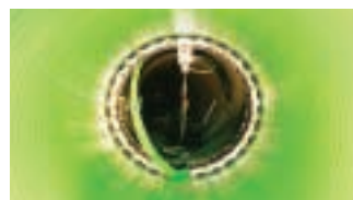
円形管更生事例
