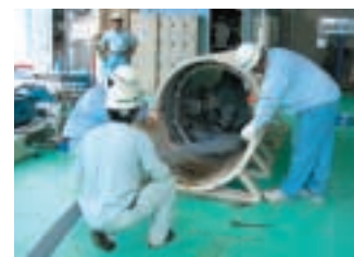
更生管トレーニングセンター (SPR工法施工研修風景)
