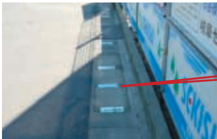
汚染対策:土砂等の側溝への侵入防止のために穴ふさぎ用プレート設置
