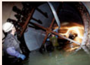
管路更生工事の様子
