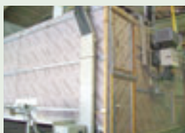
フェノバボードで覆った乾燥炉
