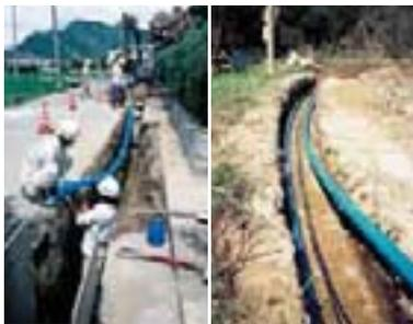
耐震性、施工性に優れた高性能管材の施工風景
