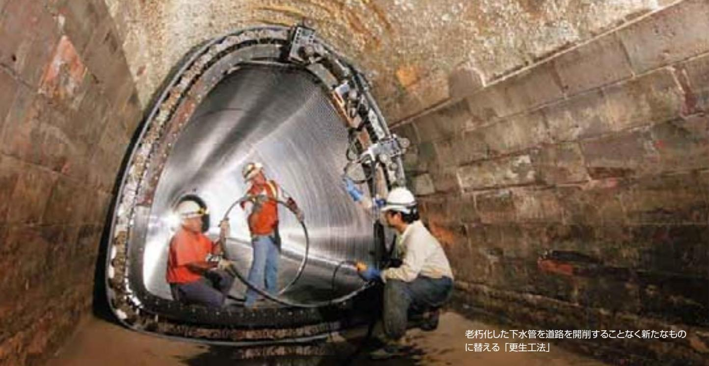
老朽化した下水管を道路を開削することなく新たなものに替える「更生工法」
