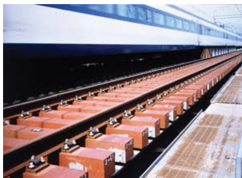
鉄道の枕木などに使用される、ガラス繊維強化プラスチック発泡体「FFU」
