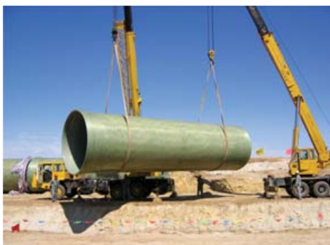
安全・安心な水インフラ創造に貢献する、ガラス繊維、不飽和ポリエステル樹脂・珪砂からなる「強化プラスチック複合管」
