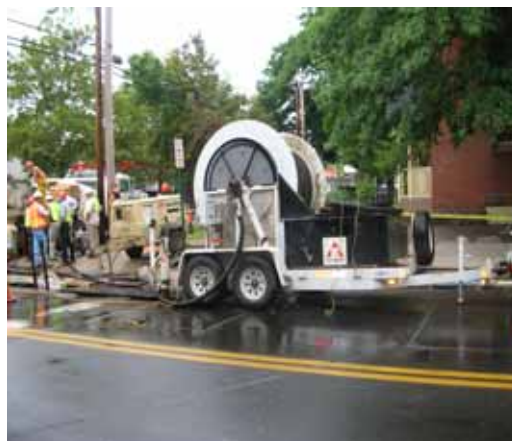
管路更生工事現場
