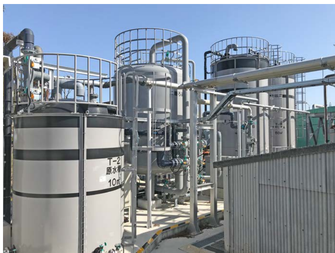
滋賀水口工場のろ過設備
