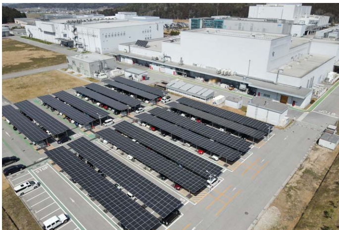
積水化学工業(株) 多賀工場
