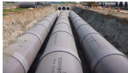
FRPM管+レインステーションで道路対策
