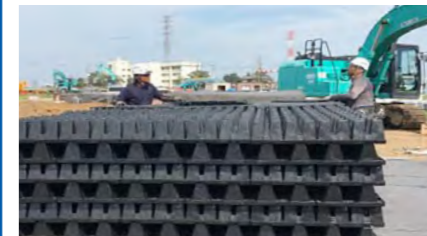
クロスウェーブは敷地内対策(地下型調整池<上部公園等利用>)
