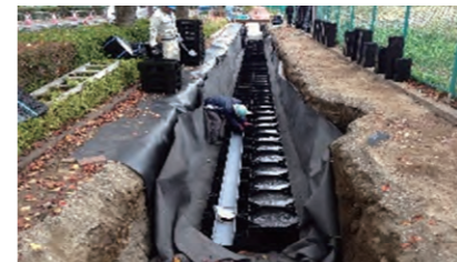
FRPM管+レインステーションで道路対策
