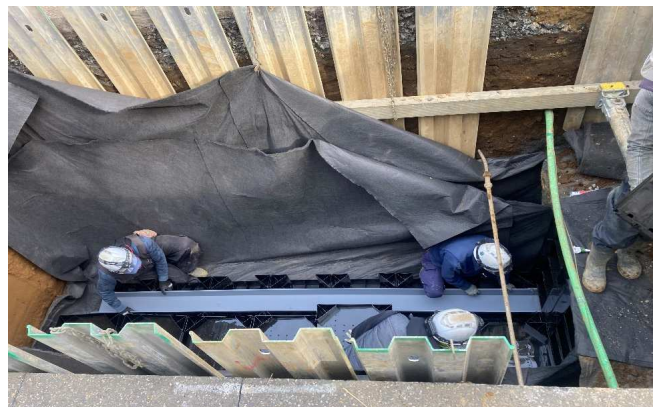
業者(田中土木様)のレインステーション施工状況
