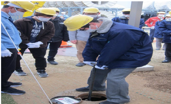
災害用トイレシステム/ゲート開閉作業
