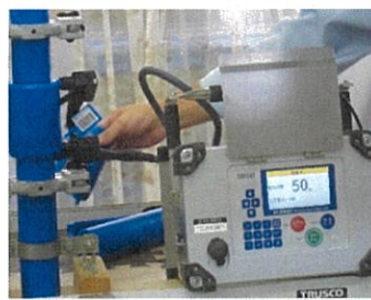
<エスロハイパーAWの電気融着および標準施工を実演します>
