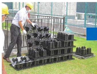
＜CWトレンチSSを実際に組み立てます＞
