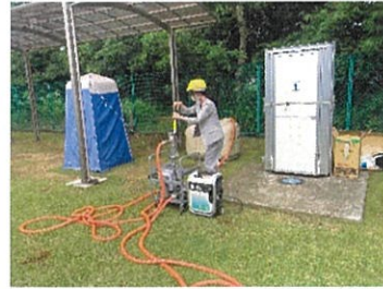
＜可搬式ポンプや仮設給水栓を実際に組み立て水を出します＞
