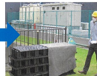
＜CWトレンチSSを実際に組み立てます＞
