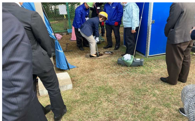
災害用トイレのゲート弁開閉体験
