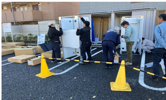
(株)総合サービス様/パネル式建屋の組立作業
