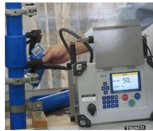
＜エスロハイパーAWの電気融着および標準施工を実演します＞
