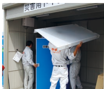
災害用パネル式トイレ設置の様子
