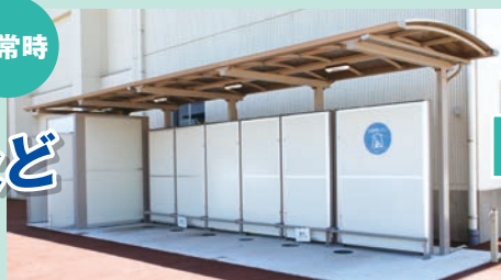
自転車置場兼災害用トイレブース
