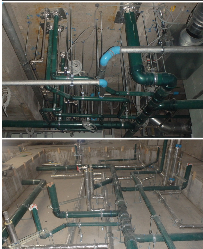
耐火VPパイプ 保温レス施工 (世田谷区立瀬田小学校)
