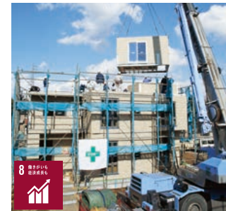
住宅ユニットの据え付け風景
