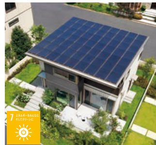
大容量太陽光発電システム
