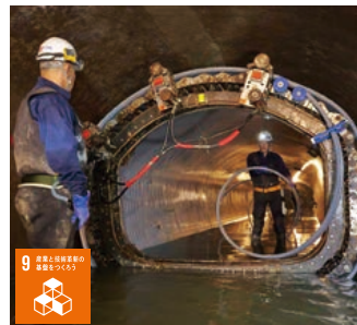
下水道管路更生
