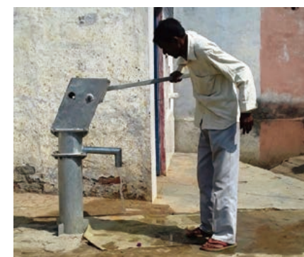
安全な飲料水確保に悩むインドの村に水ポンプを設置
