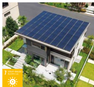
大容量太陽光発電システム
