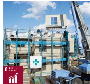
住宅ユニットの据え付け風景
