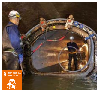
管路更生工法 (SPR工法)
