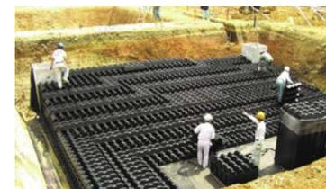
豪雨時、下水道等流れ込む雨水の量を調節。アジア諸国での慢性的な水不足への対策、都市緑化および防災を目的とした雨水の循環利用、洪水における災害対策に貢献。
