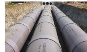
軽量で地盤が緩い場所でも施工可能。農業・空港施設・水力発電等に幅広く使われる。管内に雨水の貯留が可能でまちや建物の集中豪雨対策にも貢献。
