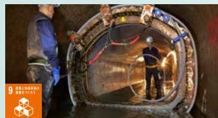
管路更生工法 (SPR工法)
