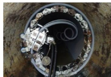
既設管の内側に施工し道路を掘り返さずに、老朽化した下水道をリニューアル。少人数・短工期で施工可能で廃棄物の大幅な削減も実現。
