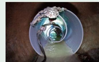
既設管の内側に施工。道路を掘り返さずに老朽化した下水道をリニューアルできるため、少工数かつ短工期で施工でき、天候に左右されず、工事騒音も抑えることが可能です。また、廃棄物の大幅な削減も実現できます。
