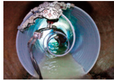
下水管などインフラ老朽化に貢献するSPR工法
