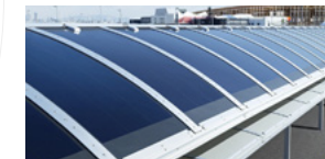
大阪・関西万博内バスターミナルに設置されたフィルム型ペロブスカイト太陽電池
