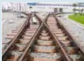
FFUまくらぎ使用例 広州地下鉄8号線 車両基地
