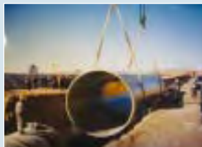
強化プラスチック複合管の施工風景（上海）
