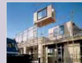
棟上げもわずか1日で完了する速施工
