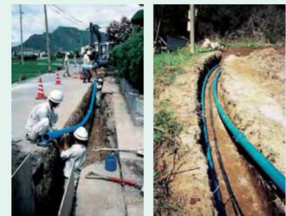
耐震性、施工性に優れた高性能管の施工風景
