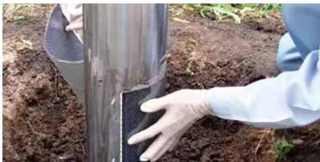
現場での施工の様子
