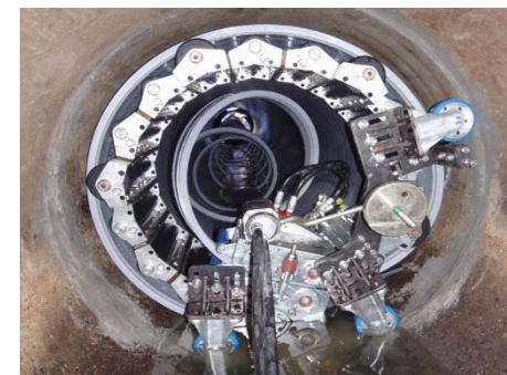
管路更生「SPR工法」
