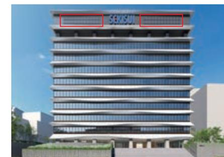
▲大阪本社ビル 外壁に実装 (赤枠内がフィルム型ペロブスカイト太陽電池)
