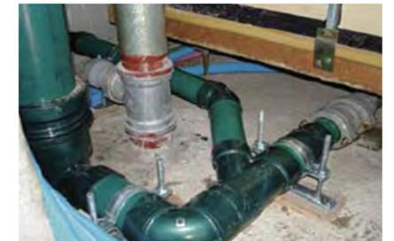
「エスロン耐火VPパイプ」は、塩ビ管だけで防火区画の貫通が可能になった業界初の三層構造の耐火性プラスチック管です。改修工事の際、既存の配管スペースをそのまま利用できるため、リニューアル工事での採用が拡大しています。
