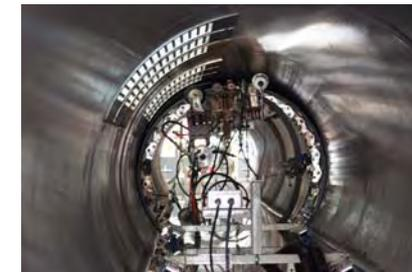
老朽化した下水管を掘削せずに再生する管路更生事業では、「SPR工法」をさらに進化させた「自動化SPR工法」を開発しました。製管を自動化することにより約20%の工期短縮が可能となるとともに、より安全性の高い施工を実現します。
