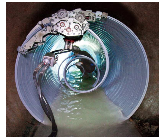
管路更生工法 「SPR-NX工法」
