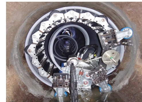
管路更生「SPR工法」
